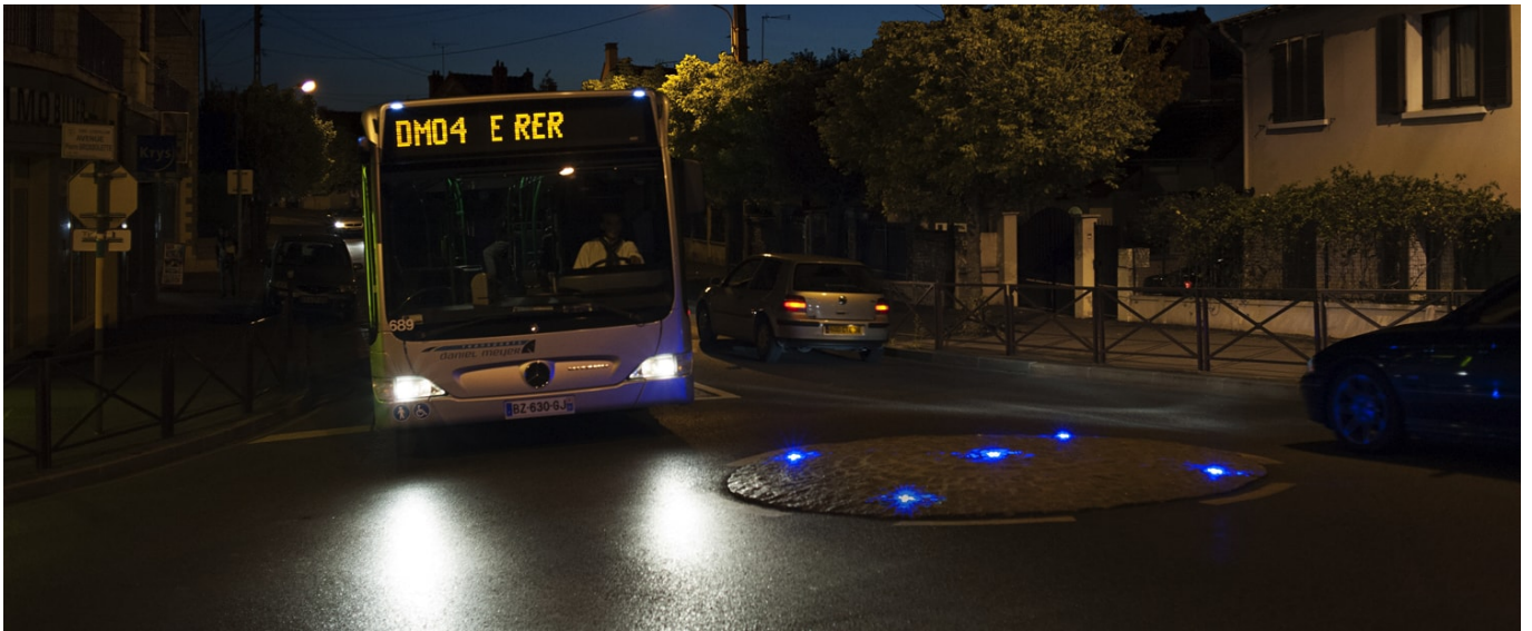
Mini-giratoire LED franchissable. Balisage de sécurité d'un mini-giratoire franchissable par des véhicules en centre-ville à Viry-Châtillon. Plots routiers encastrés très basse tension ECO-870 (24 LED bleues fixes visibles à 360 degrés). Photographie : Karolina Samborska.
