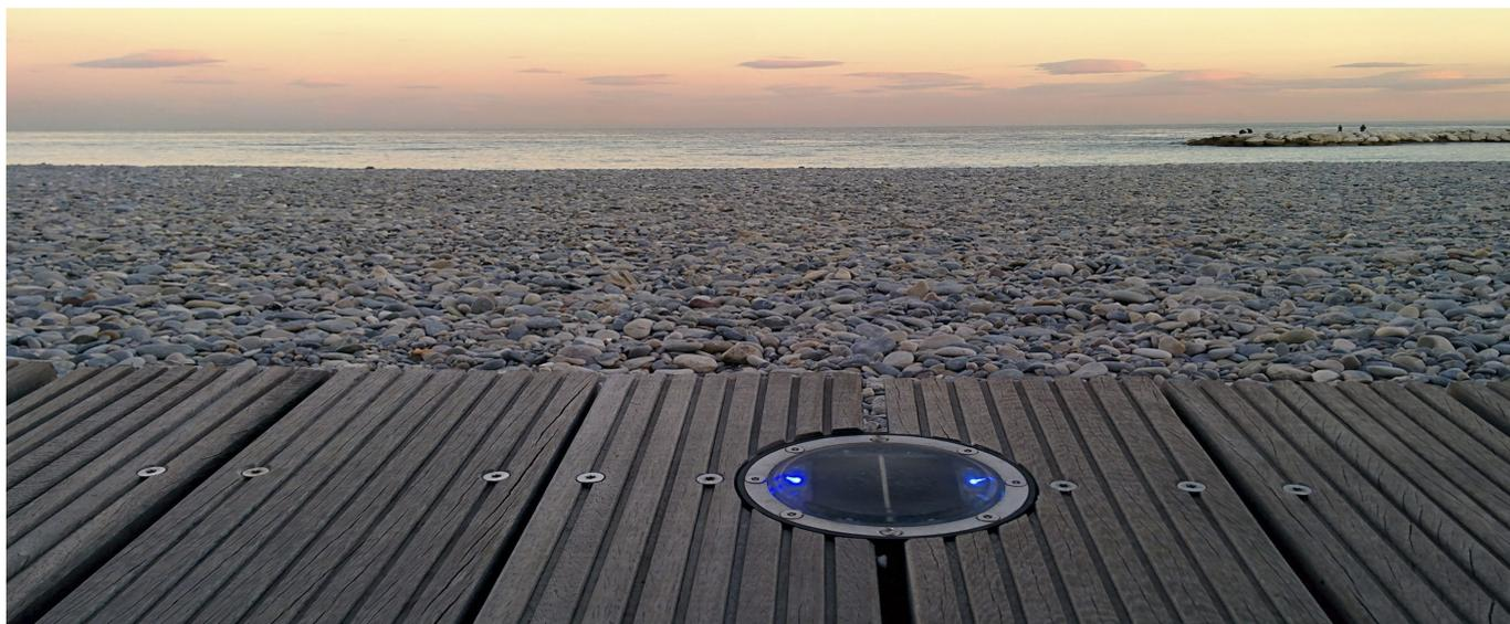
**Balisage de promenade en bord de mer.** Guidage des piétons sur un platelage en bois immergeable (sentier du littoral) à Villeneuve Loubet (06). Plots solaires encastrés ECO-128 (balisage bidirectionnel 1 LED bleue fixe par côté).
