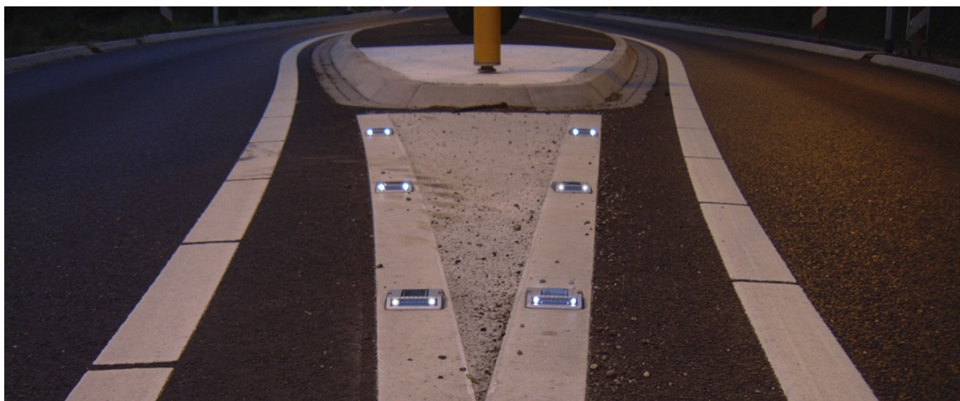
Balisage de sécurité d'une tête d'îlot. Balisage de sécurité d'une tête d'îlot non franchissable par les véhicules. Balises solaires hors sol ECO-118 (unidirectionnel 2 LED blanches clignotantes).
