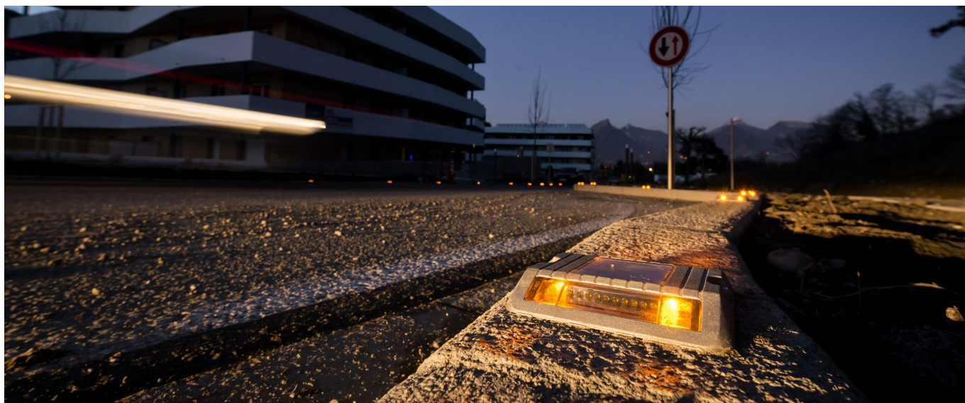
Balisage de sécurité LED sur rétrécissement de chaussée. Signalisation de sécurité sur une "zone 30" à Seyssins (38). Balises solaires ECO-118 avec 2 LED ambres clignotantes par côté. Photographie : Jérôme Deduysche.
