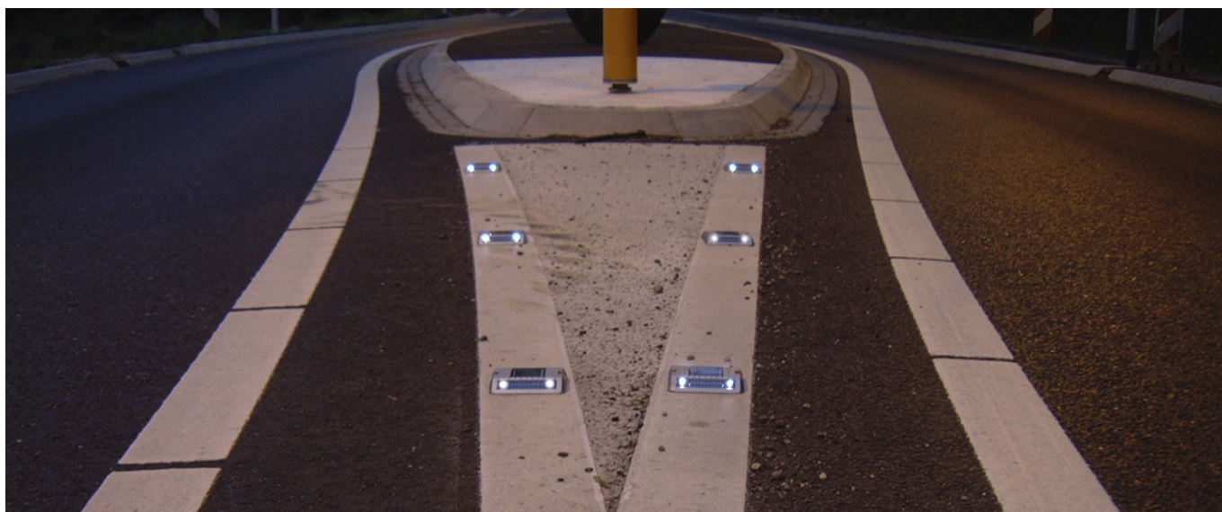
Balisage de sécurité d'une tête d'îlot. Balisage de sécurité d'une tête d'îlot non franchissable par les véhicules. Balises solaires hors sol ECO-118 (unidirectionnel 2 LED blanches clignotantes).
